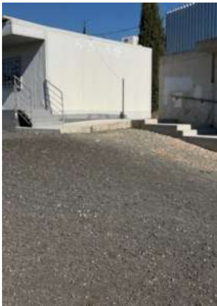
Εικόνα 2: Προκατασκευασμένη αίθουσα στην αυλή του Γ' Δημοτικού Σχολείου Ύψωνα
